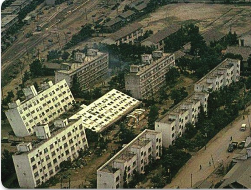
الشكل 19-7 يحدث تسييل في التربة الضعيفة التماسك عندما تنتشر اهتزازات زلزالية فيها، فتسلك سلوك الرمال المتحركة.
