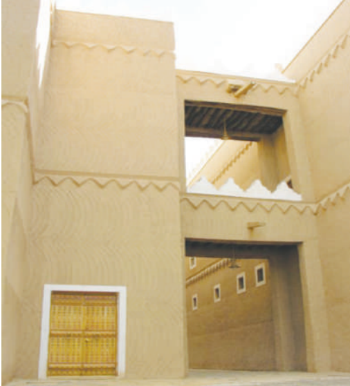
الشكل (٢) البيوت الشعبية في منطقة المربع بالرياض
